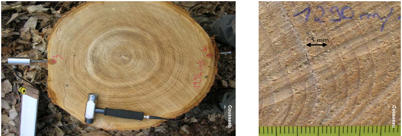
Figure n°90 : Le seuil de détection de la roulure à l'aide du marteau à ondes sonores
