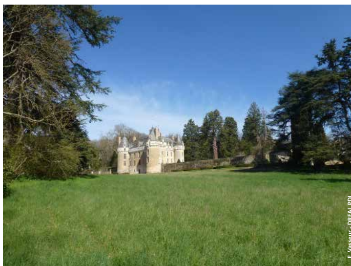
Vue du château de Gallerande.
