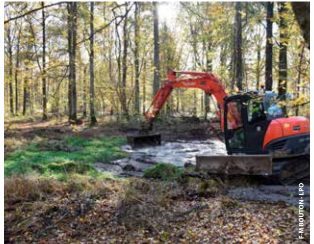
Une mare forestière en cours de restauration, le 13 novembre 2017.
