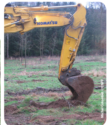
Travail du sol avec godet sur pelle.
