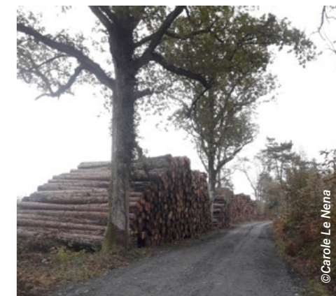
Remise en état de la voirie - Baugé en Anjou (49)
