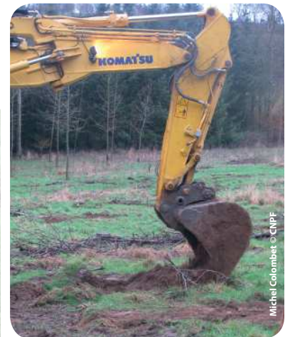
Travail du sol avec godet sur pelle.
